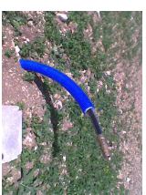
Sortie pour compteur AEP Eau potable
